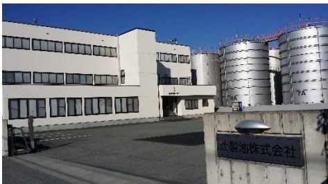
(本社事務所外観)
