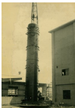
写真) 脱臭塔設置
