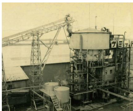
写真) ロートセル型抽出機
